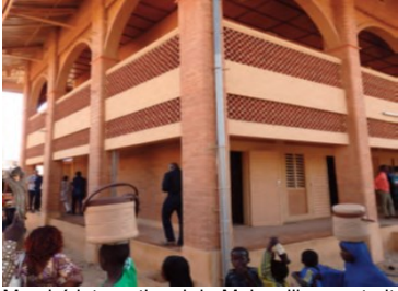
Marché international de Malanville construit en matériaux locaux par le P-DIEM - © DDC Benin
