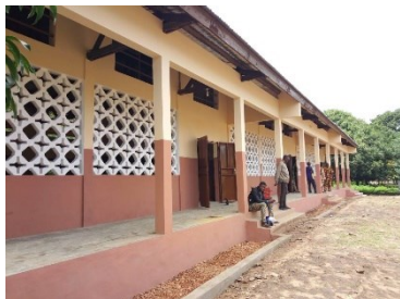
Ecole construite sur fonds FADEC © DDC Bénin
