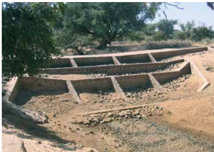
Province de Téra (Niger): aménagement de seuils d'épandage dans le fleuve (photo: DIE)
