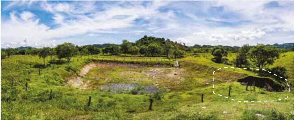
*Una mala selección del sitio, un mal diseño o una mala construcción provocan daños en el reservorio que pueden inutilizarlo completamente. En la foto, rotura del talud. Foto: CATIE.*
