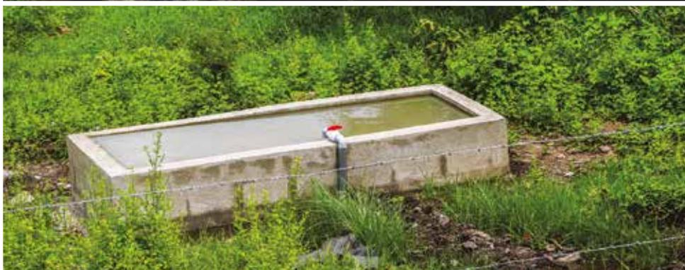
*La llave de paso o grifo es necesaria para controlar el volumen de agua en el reservorio. Abrevadero construido por el Proyecto Adaptación de la Agricultura al Cambio Climático a través de la Cosecha de Agua en Nicaragua. Fotos: CATIE.*
