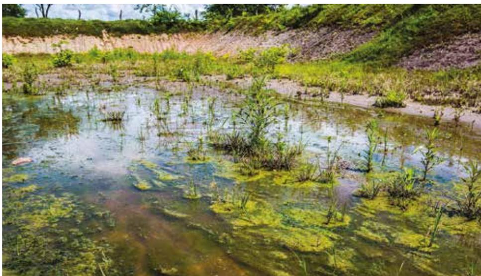
*Suelos porosos y permeables, sumados a la deficiente impermeabilización en el vaso del reservorio, ocasionan altos niveles de infiltración del agua de esorrentía. Foto: CATIE.*
