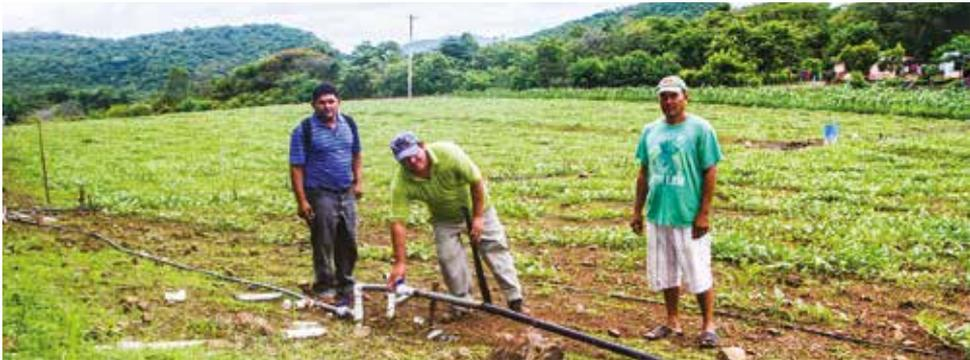
*Foto superior: línea de conducción. Sobre estas líneas, se muestra la tubería principal con la llave de paso. Al fondo, el área de cultivo con riego por goteo. Fotos: CATIE.*
