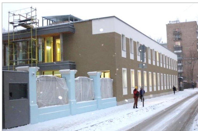
Aussenarbeiten Übergang Altbau zu Neubau
