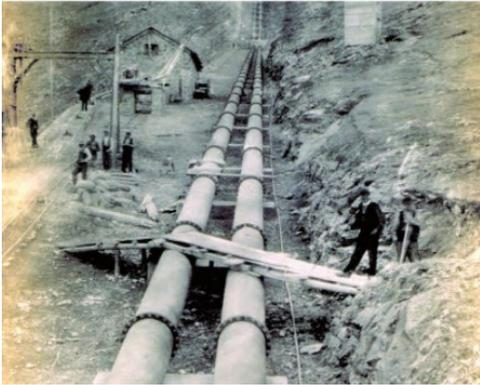
de meses, se culminó la carretera de La Pobla de Segur a Senterada y Capdella y se empezó a levantar la presa del embalse Gento a 2.415 metros de altitud para conectarla con sus lagos más próximos a través de un canal de 4.848 metros de longitud que conducía el agua desde el lago regulador hasta la cámara del salto y, de allí, hasta la central de Capdella. Una obra colosal que contaba con turbinas Pelton construidas por la empresa suiza Escher Wyss & Cie.
