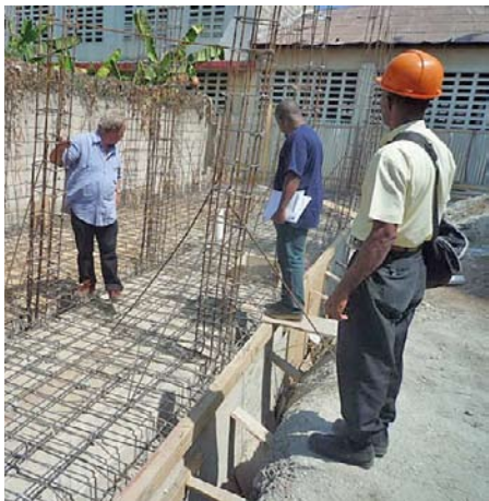
Die Baustellen werden regelmässig von Experten des Erziehungsministeriums auf Einhaltung der Baunormen geprüft.
