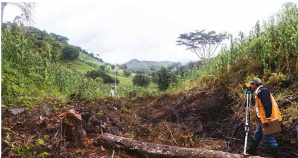
*Labores de medición y corrección en el sitio seleccionado para construir el reservorio. Foto: CATIE.*
