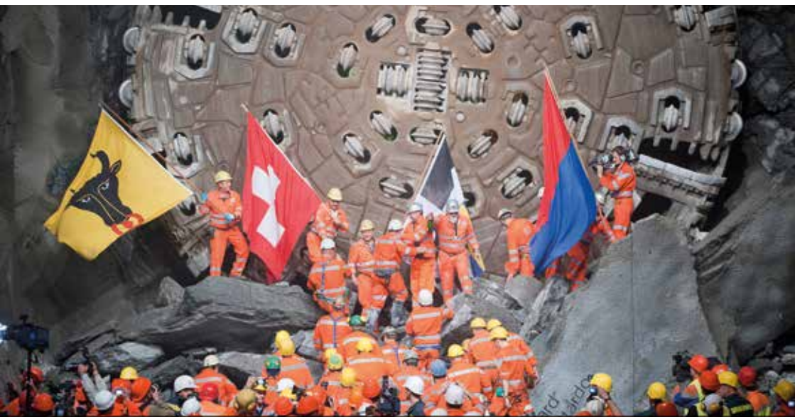
Caduta del diaframma principale presso Sedrun nella galleria di base del San Gottardo il 15 ottobre 2010. Apertura il 1° giugno 2016. Secondo l'orario ufficiale i treni transitano attraverso il più lungo traforo ferroviario del mondo alla fine del 2016. AlpTransit Gotthard AG
